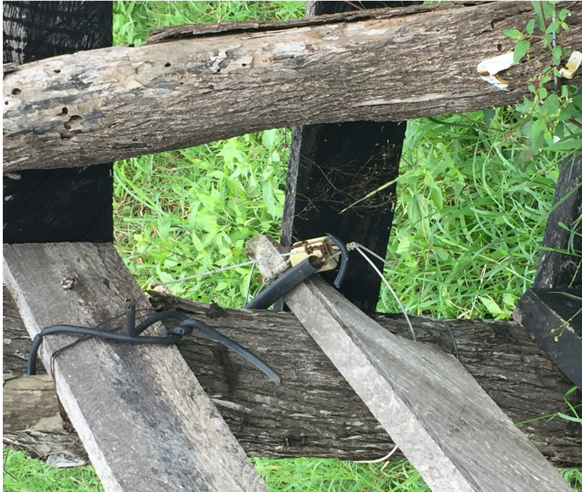
Imagen 10 Fuente Fotos de visita de campo
